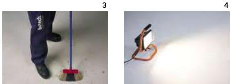
3 La superficie a revestir debe estar totalmente limpia de polvo o cualquier otra sustancia que pueda perjudicar la adhesión de las baldosas. Para colocaciones específicas (sistemas de calefacción radiante, fachadas con anclajes mecánicos, cerámica en techos ó resolución de parámetros particulares de proyecto) solicitar información concreta adicional para cada situación.
