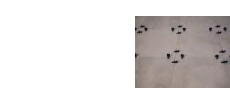
11 Respectar las juntas estructurales. Realizar las juntas de movimiento según las indicaciones del técnico de la obra. En general, no diseñar áreas superiores a 50-70 m<sup>2</sup> en interiores y la mitad en exteriores. Anchura mínima de la junta: 8 mm.
